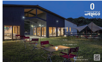
伊豆大島のコワーキングスペースも手掛けている
