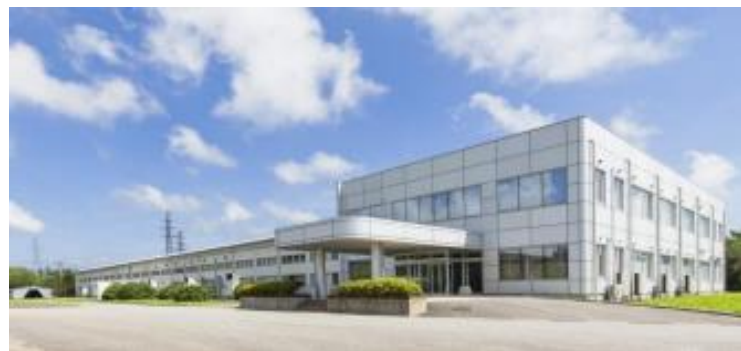
石川工場（石川県志賀町）
