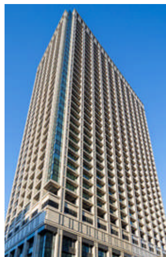
東京本社（日本橋）
