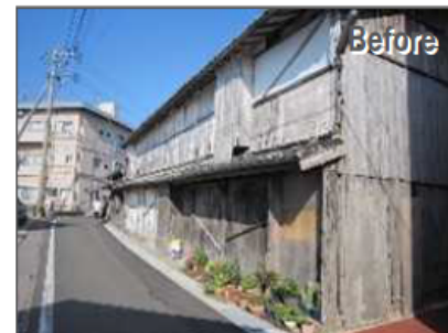
空き家の除却
