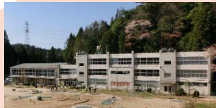
旧築羽小学校 廃校になった小学校を活用 整備・運用
