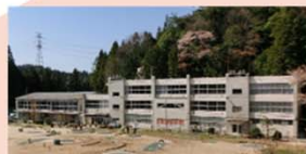
旧築羽小学校 廃校になった小学校を活用
